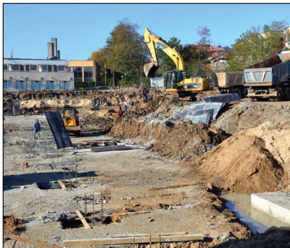
Строителите работят ударно, за да използват сухите дни до края на годината
