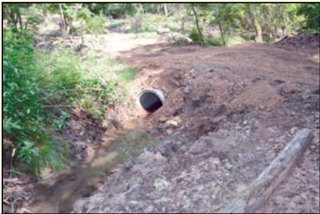
Монтираните тръби не допускат затлачване и просветляване на горските дерета при обилни валежи
